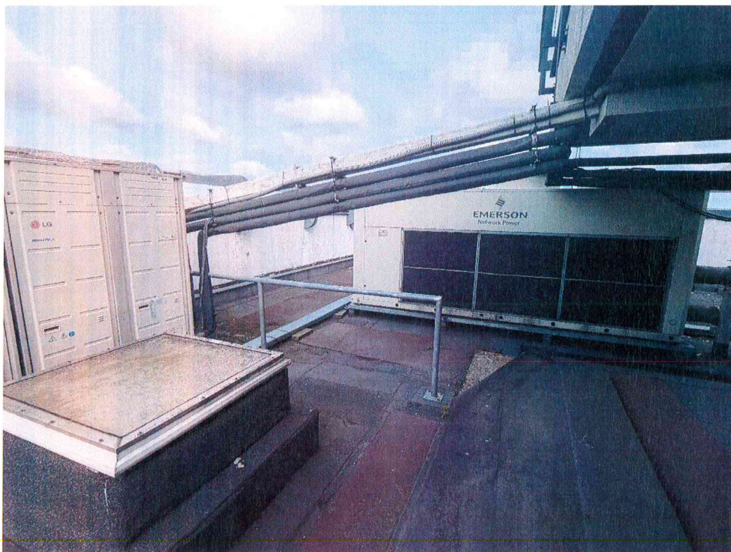
Fot. 6. Widok dolnego poziomu dachu.
