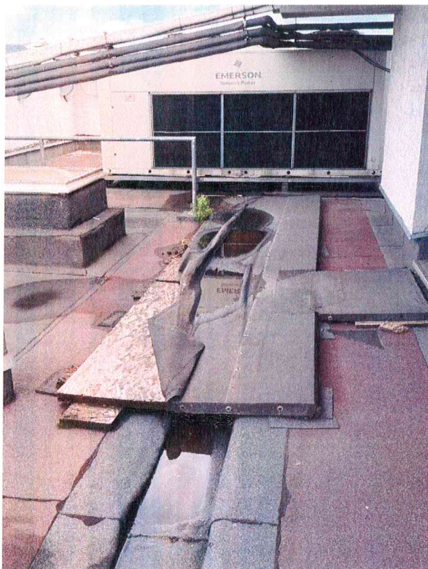
Fot. 5. Widok dolnego poziomu dachu wraz z urządzeniami i innymi elementami.
